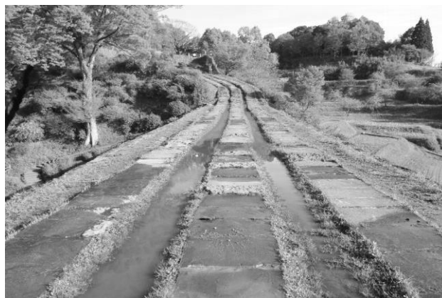
(b) 通水管からの漏水状況
