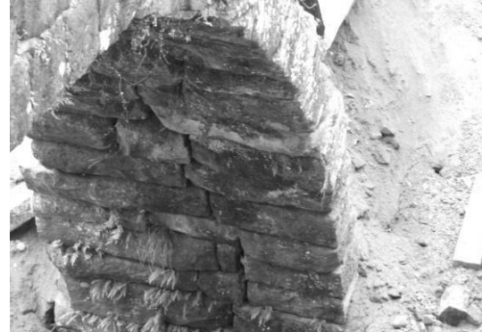
(d) アーチ輪石のすき間の状況
