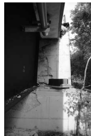
写真-12 G1 側への桁の移動と支承の回転
