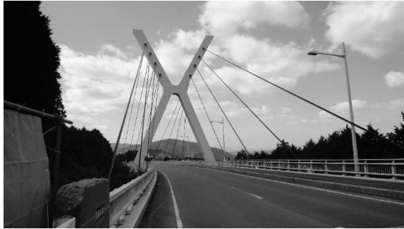
写真-15 桑鶴大橋（2011.3 撮影）
