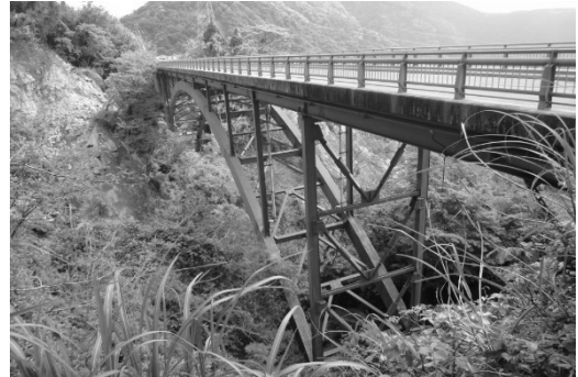
写真-H7 南阿蘇大橋の全景 (奥が A2)
