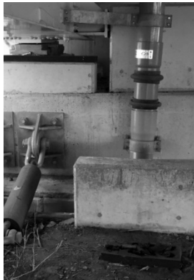
写真-17 A1 側支承・落防システム
