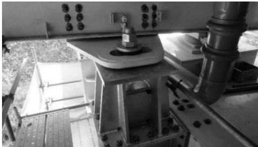
写真-16 支承の 4 隅に設置された桁変位制限装置（主塔横梁上）（2011.3 撮影）
