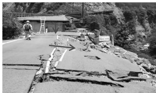
写真-2 A1 側桁端を望む位置での道路の状況
