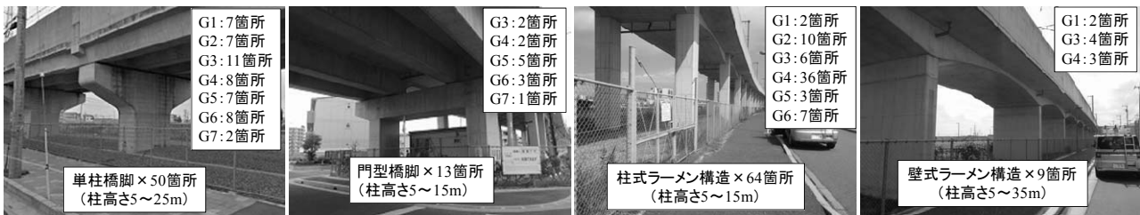
図-2 常時微動観測を実施した構造物の例
