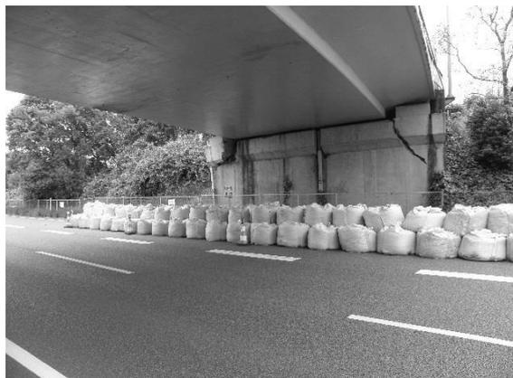
写真—1 東原橋損傷状況
