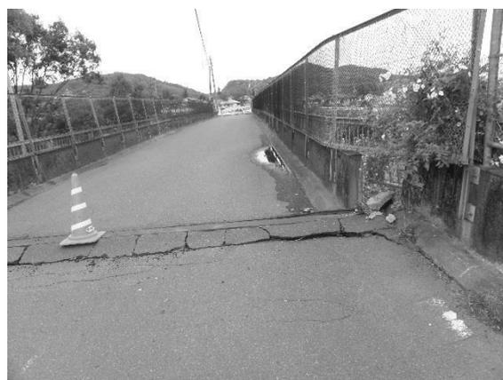
写真—2 神園橋損傷状況
