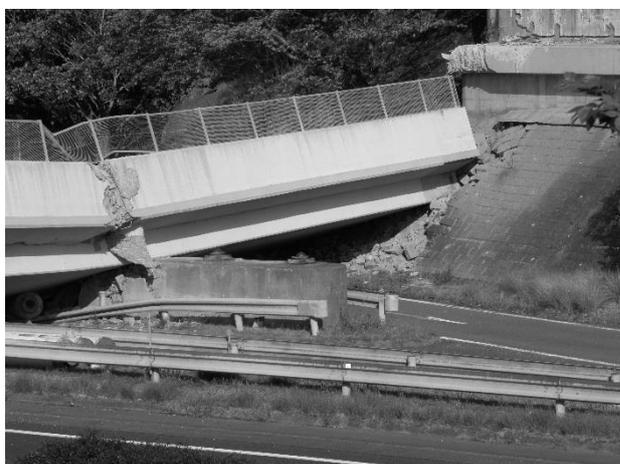
写真—4 北側桁端部落橋状況
