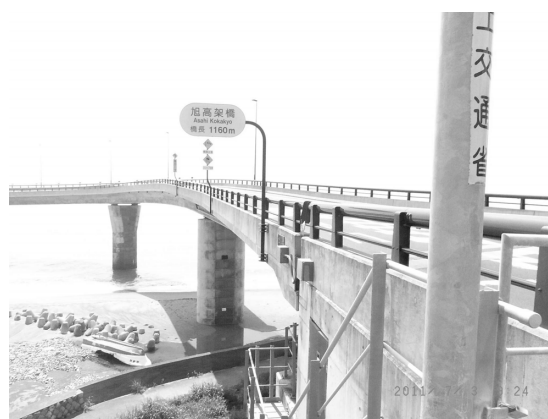
写真-1 検討対象とした旭高架橋のランプ部
