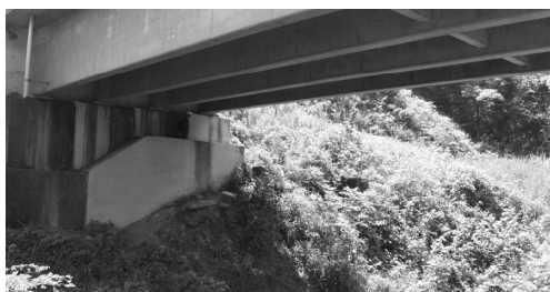
写真-7 すすきの原橋の橋台（高森側）
