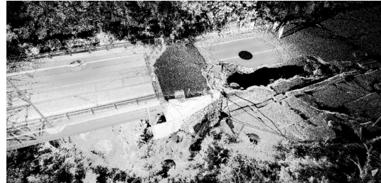
図-5 俵山大橋橋台部の3Dスキャン（上方から）
