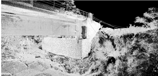
図-4 俵山大橋橋台部の3Dスキャン
