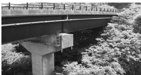
写真-9 俵山大橋（P2 橋脚付近）
