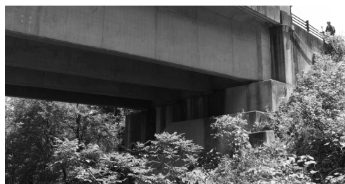
写真-8 すすきの原橋の橋台（熊本側）
