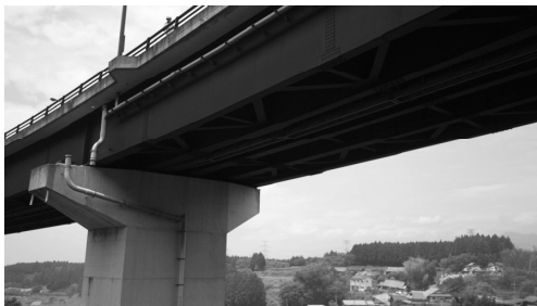
写真-3 大切畑大橋（橋桁の撮影）
