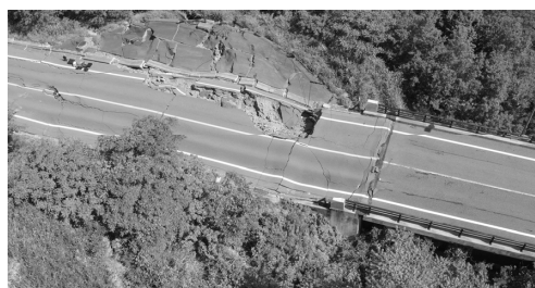
写真-10 俵山大橋端部（熊本側）
