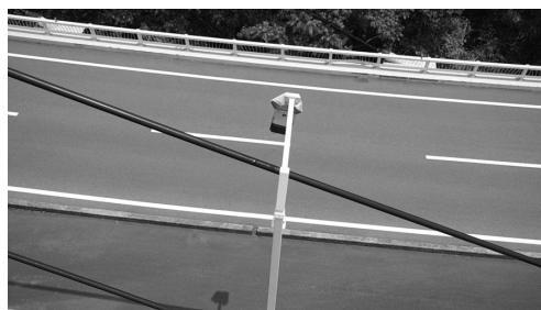
写真-6 桑鶴大橋（ケーブルとの接触）
