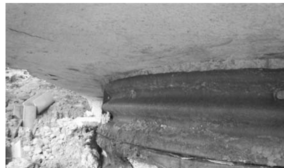
写真-4 A1 橋台の深礎杭の杭頭（無損傷）
