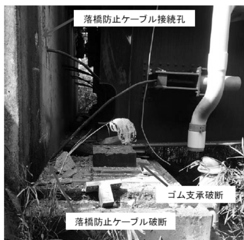
(a) 橋台部側面
