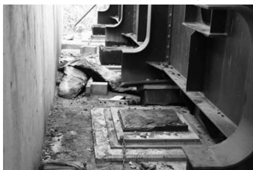
(b) 主桁～パラペット(胸壁)間
