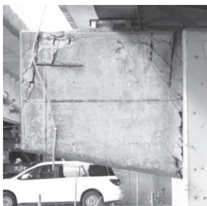
(ii) 横梁における鉛直方向のひび割れ (P1)
