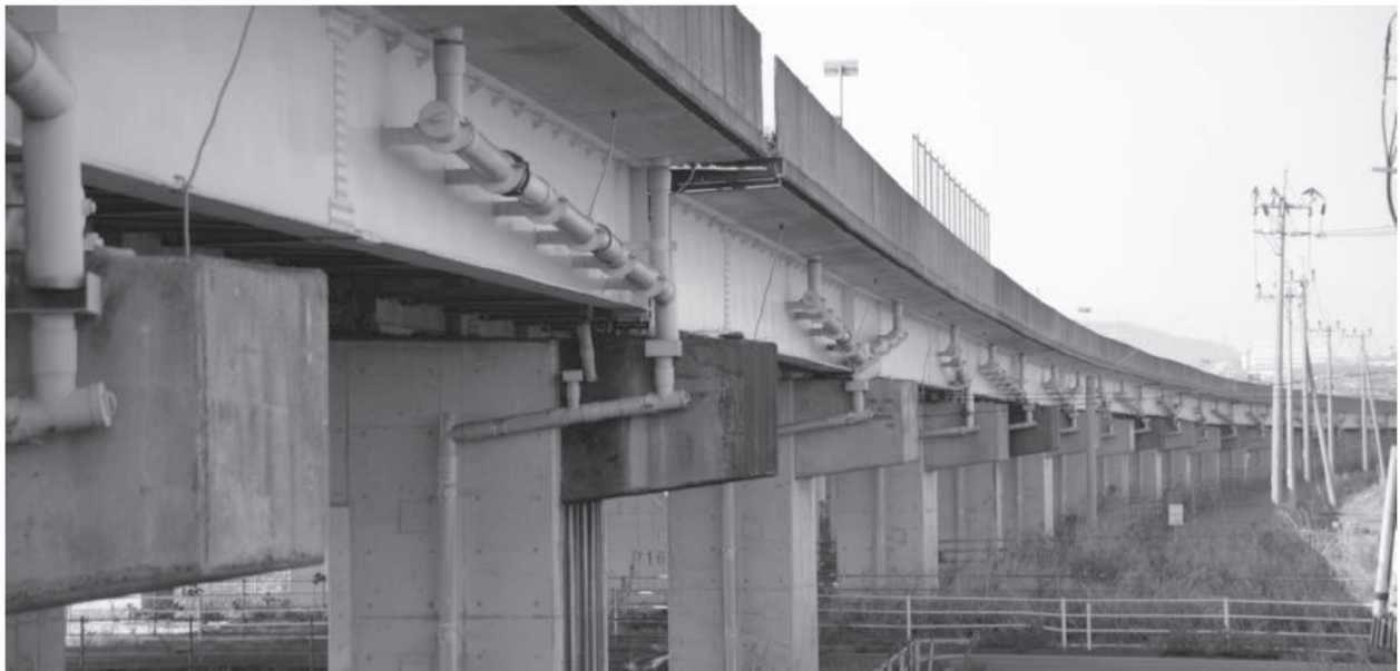
図-2 木山川橋を木山川から北側へ望む（4月15日撮影）
