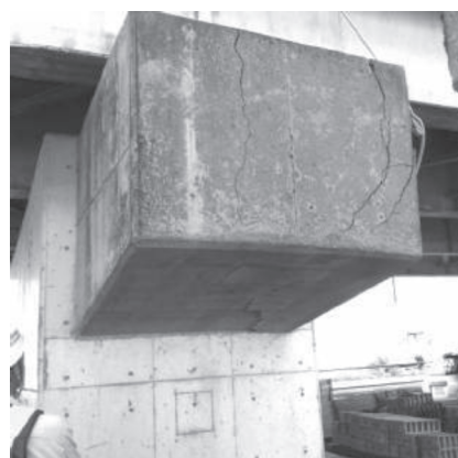
(ii) 横梁における鉛直方向のひび割れ (P1)
