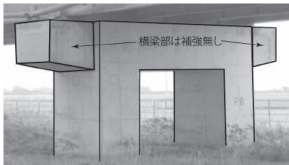
図-4 木山川橋橋脚の耐震補強状況
