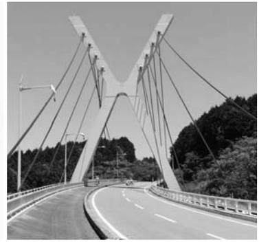
写真-17 主塔および曲線桁写真
