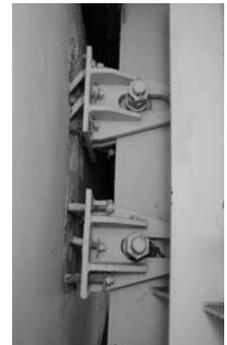
写真-22 移動制限装置アンカー抜出し
