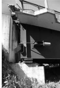
写真-11 A2橋台が前傾し桁と接触
