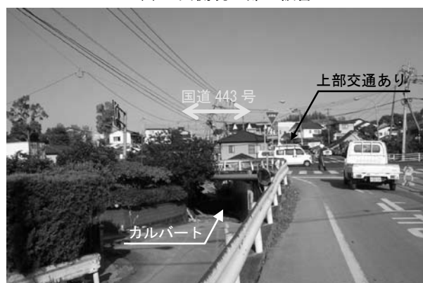
(b) 東側坑口部
