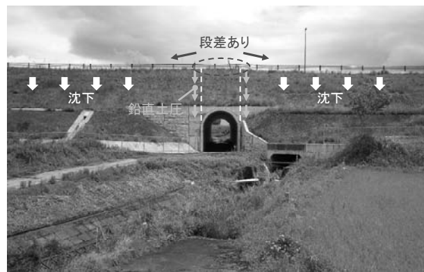
写真-6 カルバート上部盛土の状況
