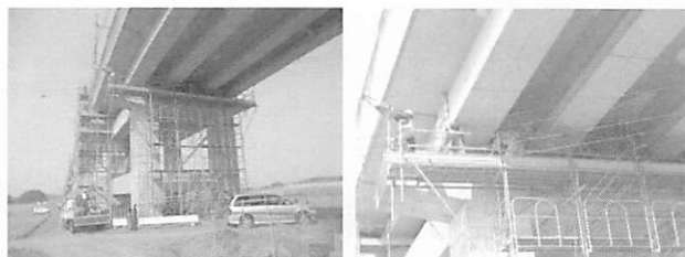
写真-5 足場設置及び人力による復旧工事
