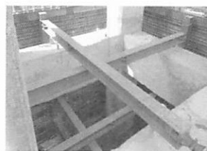
写真-12 土留め工設置状況
