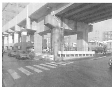
写真-11 設置位置全景
