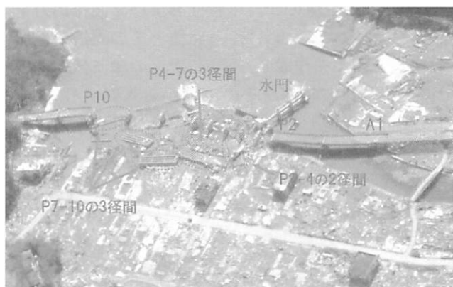
図-1 歌津大橋の被災状況（2011.3.19 東北地方整備局撮影）
