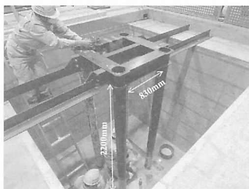
図-2 地盤作成前の試験杭の状況
