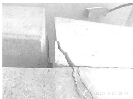
(1) 橋軸直角方向の水平力を負担する拘束部材と橋台頂部接合部（橋座部）付近の損傷
