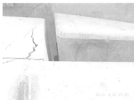
(1) 橋軸直角方向の水平力を負担する拘束部材と橋台頂部接合部（橋座部）付近の損傷
