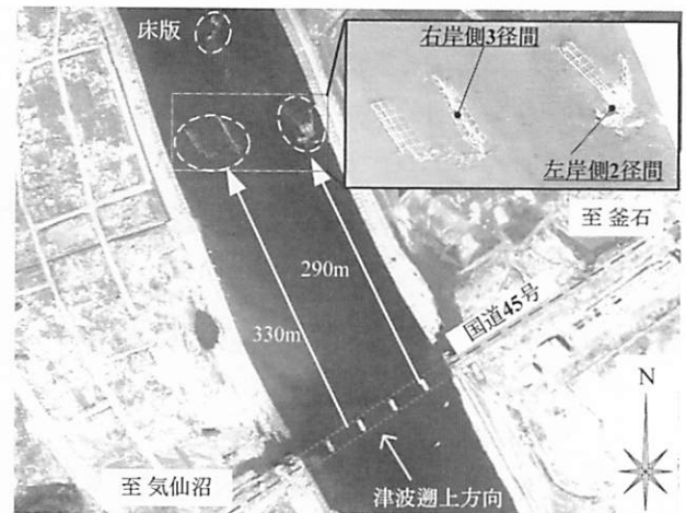
図-3 気仙大橋の流出被害状況
