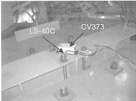
図-4 錘上部に設置した加速度計設置状況 (CV373, LS-40C のサンプリング周波数はそれぞれ 200 Hz と 10 kHz である)
