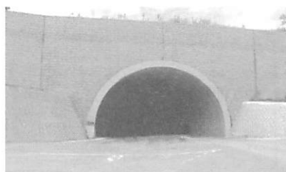
写真-1 アーチカルバート
