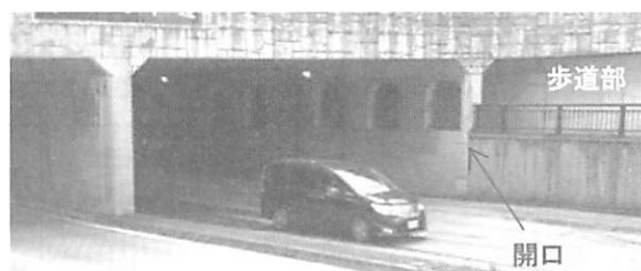
写真-1 中壁に開口が設けられている状況
