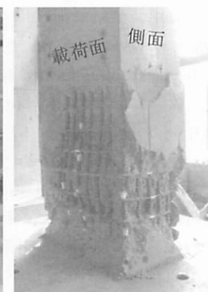
(b) 試験終了後（補強材撤去）
