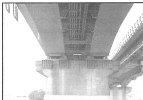
写真-14 免震橋に添架された通信管
