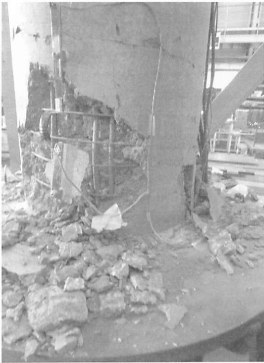
写真 1 1000gal 加振後の無対策電化柱基部
