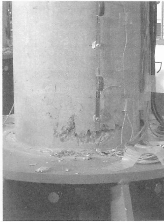
写真 2 1000gal 加振後の H 鋼挿入電化柱基部
