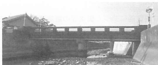
写真-1 加振実験で対象とした前場橋
