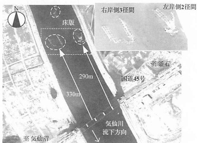
図-4 気仙大橋の流出状況
