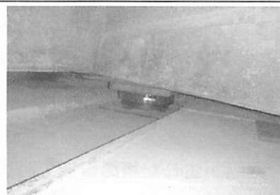
写真-4 主桁ジャッキアップ状況
