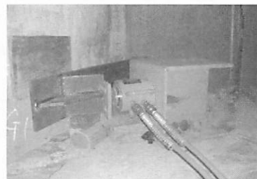
写真-5 主桁回転設置ジャッキ状況
