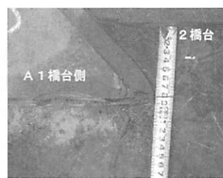
写真-1 P1桁移動量 82mm
