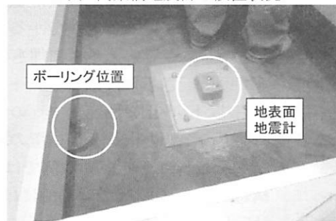
(c) 地表面地震計の設置状況
