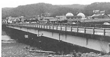
写真-1 対象橋梁の全景
