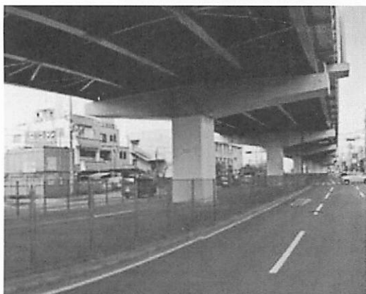
写真-2 現地状況（堺 P181）
