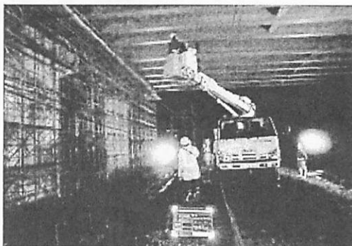
写真-2、線路上での軌陸形高所作業車による点検
