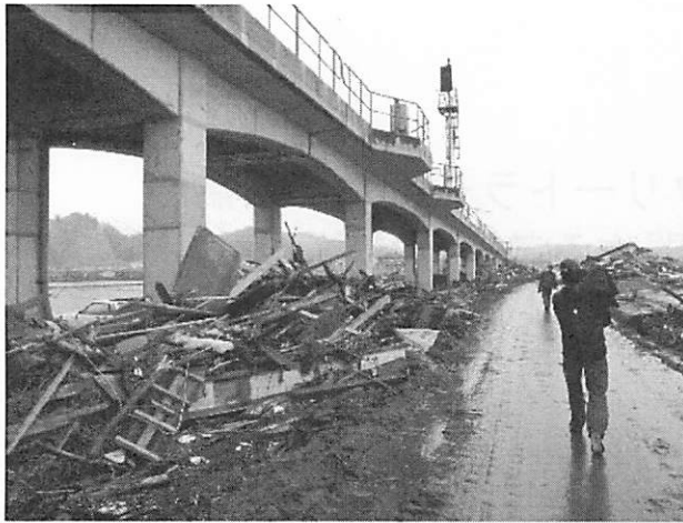
図-1 津波の影響を受けた RC1 層ラーメン高架橋
