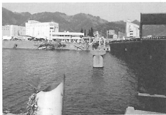
写真-1 津波来襲後の状況 (左: 下流側, 右: 上流側水管橋の流出)
