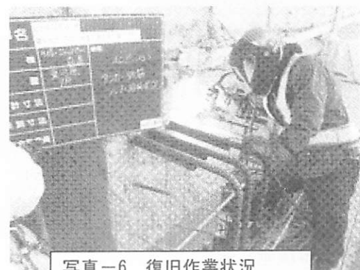
写真-6 復旧作業状況
