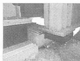
図-4 支承損傷位置図
