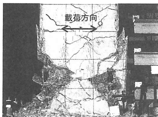
(a) 異形鉄筋供試体 (右側面基部)
