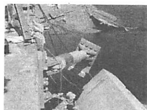
(c) 流出部の橋脚
