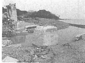
(c) 流出部の橋脚
