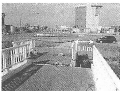
(b) 回転した上部構造 (左岸)
