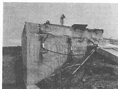
(d) 流出部の橋台
