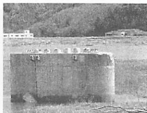
(c) 流出部の橋脚
