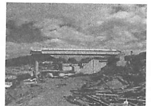
(c) 流出部の橋脚
