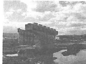
(b) 流出した上部構造
