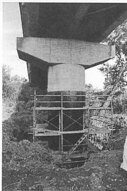
写真-32 カーボンファイバーシート巻き立てによる補強
