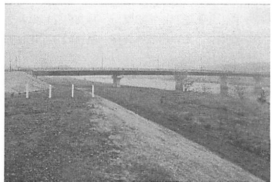
写真-35 東松島大橋
