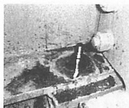
写真-7 セットボルト 応急復旧状況
