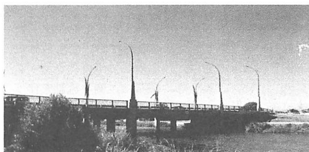
写真-8 Anzac 橋の全景
