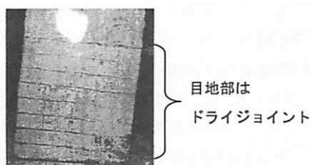
写真-3 UFC2005 試験体の基部の状況
