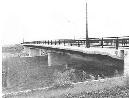
写真-1 栗原中央大橋全景
