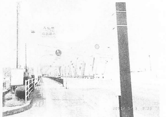
写真-14 大仏大橋全景
