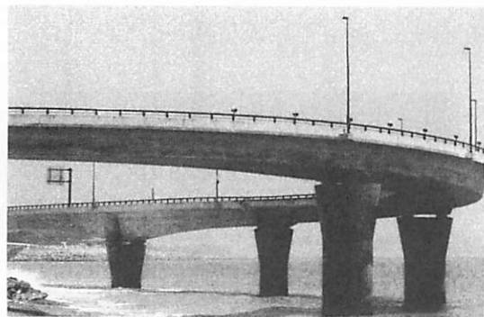
写真-6 旭高架橋：曲線部から直線部のかけ違い付近
