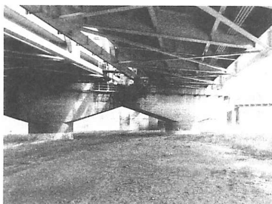
写真-17 下り線のトラス格点部位置で生じた損傷
