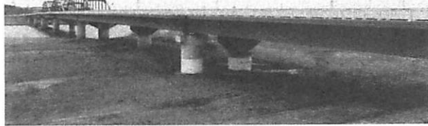
写真-9 神崎大橋全景
