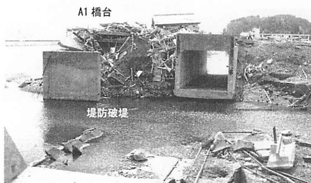
写真-5 A1橋台背面
