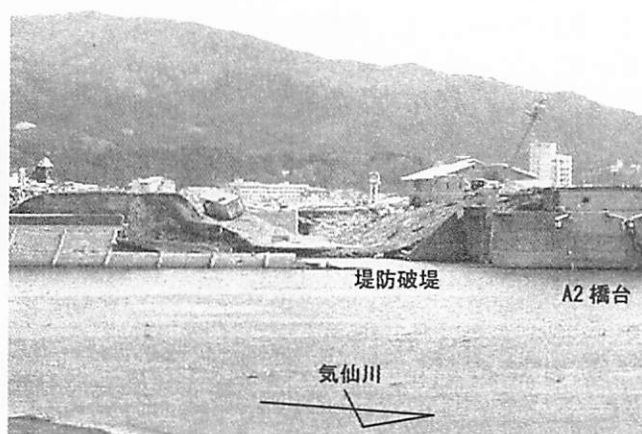
写真-6 A2橋台直上流の破堤
