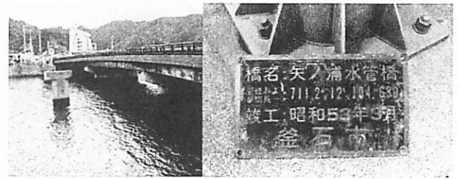
図-24 釜石の被害状況(4)
