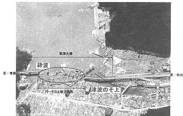
図-6 歌津大橋（延長304m）の落橋状況 9)
