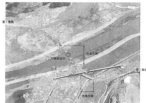
図-8 小泉大橋（延長182m）の落橋状況 9)
