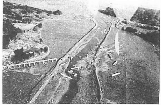
図-12 津谷川PC橋の被災後の状況 13)
