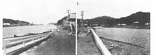
図-27 釜石の被害状況(7)
