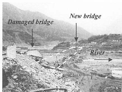
写真-14 工事中の新しいBaihua Bridge （第2回目調査）
