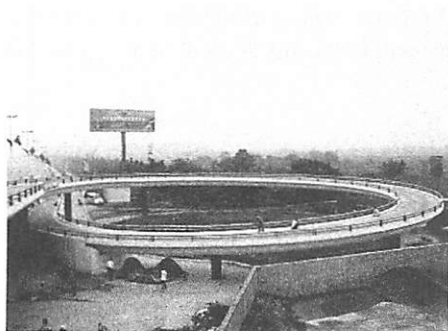
写真-17 完成したHuilan Bridgeのランプ部 (第3回目調査)
