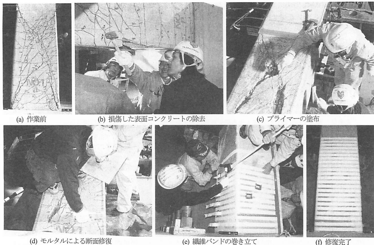
写真-1 提案工法による応急復旧
