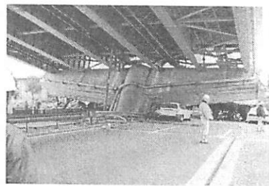
(b) せん断破壊モード
