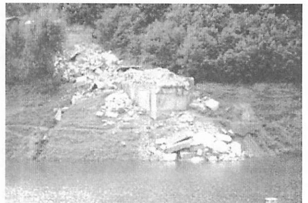
写真-8 左岸側のアーチリブ基部の破壊
