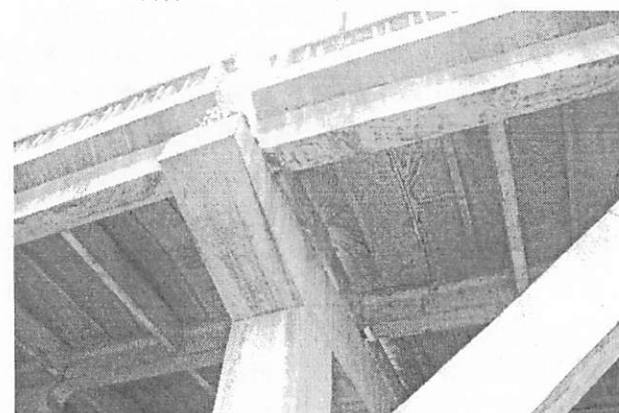
写真-18 P2 橋脚上の桁 2 の支持状態
