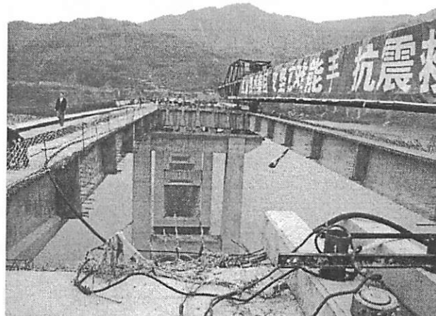
写真-11 復旧のため架設中のPCT桁
