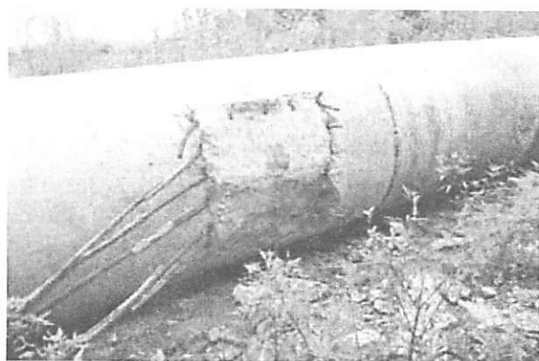
写真-8 横梁と結合されていた橋脚柱の固定部
