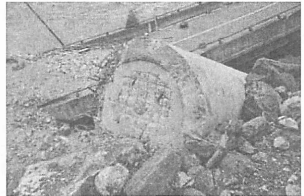
写真-4 ゴム支承が設置されていた橋脚柱上端
