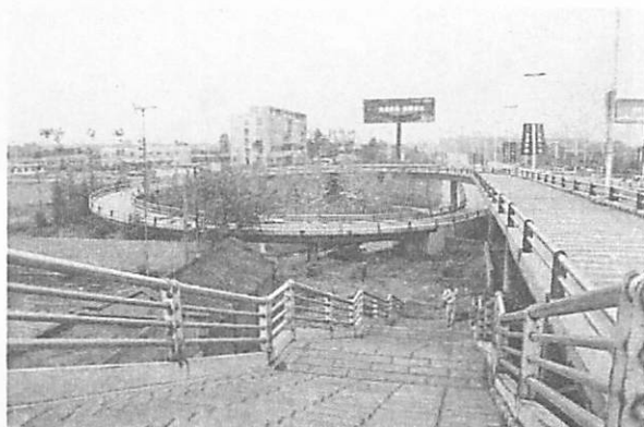
写真-10 ランプA全景
