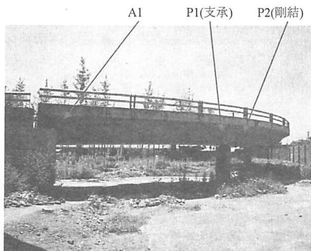
写真-12 各橋脚と支持条件
