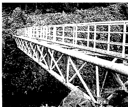
写真-2 B水管橋
