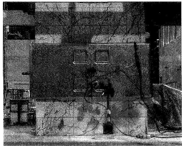
写真-2 最大荷重時の状況
